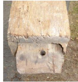
von dem Besitzer erhalten. Der hier abgebildete Balken ist ein Halsriegel von 0,80 m Länge. Sehr schön zu sehen der Schlitz und der T-Zapfen. Die Balken sind 376 Jahre alt. Wir haben sie einer gründlichen Reinigung unterzogen und mit einer Lasur gestrichen. Sie sind damit zum Anbringen an der Remise fertig.
