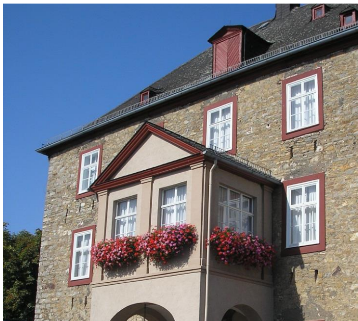
Das Bild zeigt den Vorbau mit Geranien in voller Pracht aus dem Jahre 2015.
